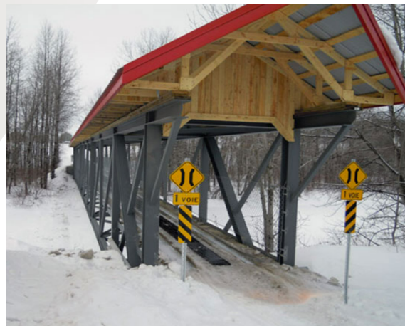
Passerelle de motoneiges, Amqui, Canada
